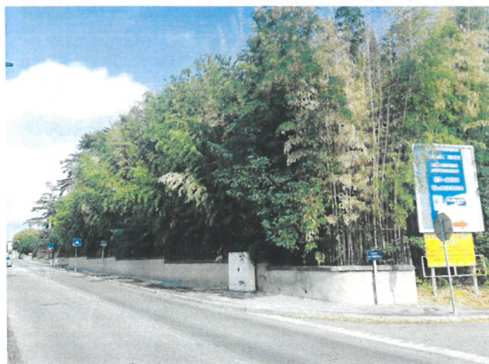
3- Vue côté route d'Uzès
